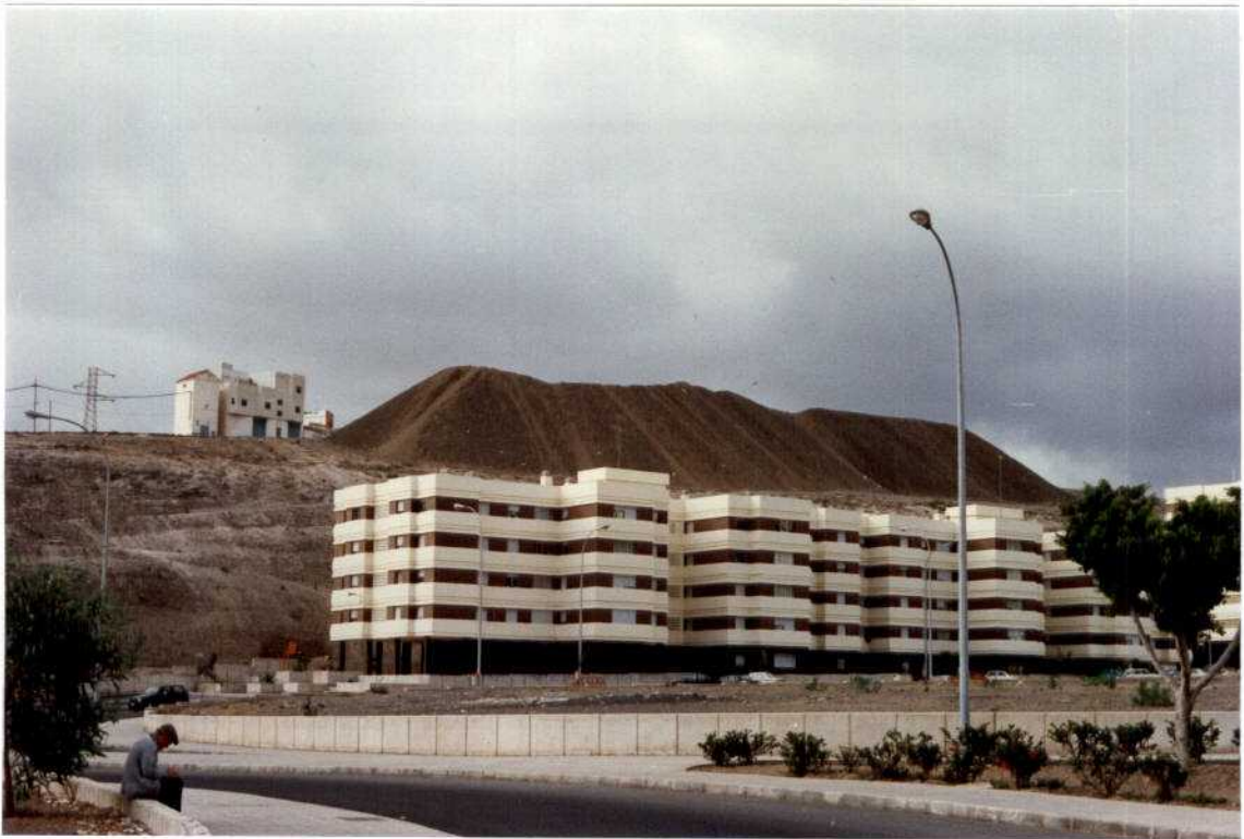
Fotg. 6 : Escombrera ubicada en la ladera con alto riesgo al haberse construido, por debajo de ella y próximo a su base una vivienda. (La vivienda es posterior a la estructura). Estructura número 4241-7-5.
